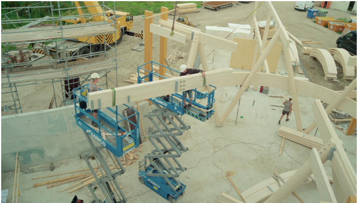
Biosintrum in aanbouw
